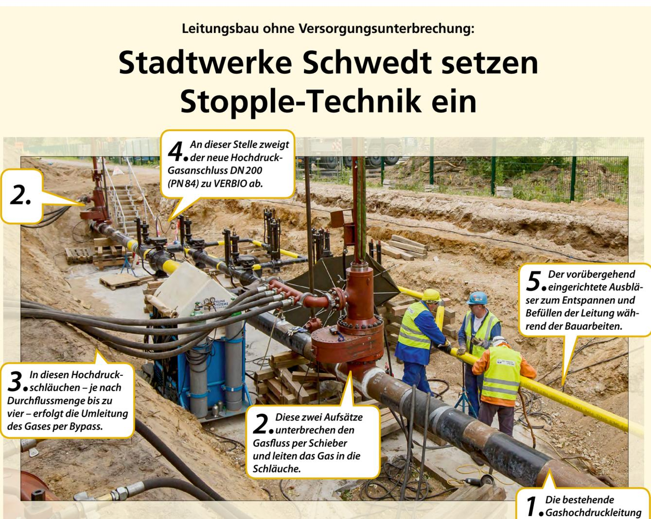
Mit der Entscheidung zum Netzanschluss durch VERBIO haben die Stadtwerke Schwedt die komplette Genehmigung, Planung und Realisierung der Anschlussleitung, mit allen notwendigen Regelanlagen, übernommen.
