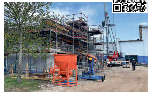
April 2023: Der Wiederaufbau ist im vollen Gange, neue Seitenwände vom Sportbad werden errichtet. Der Hochbau ist fast abgeschlossen. Das Aufmaß für die Stahlkonstruktion – sie ist nicht mehr aus Holz – wird genommen, um das Dachgestell zu fertigen.
