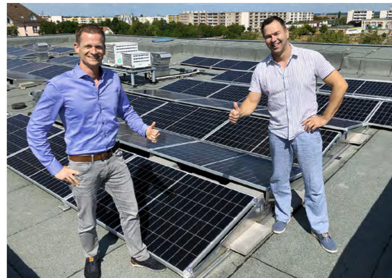
Im Pflegezentrum des DRK in Schwedt stehen 100 Betreuungsplätze zur Verfügung. Bei der Installation der PV-Anlage arbeitete Christoph Standtke (l.) von den Stadtwerken eng mit DRK-Vorstand Ringo Lüdcke zusammen. Foto: SWS
