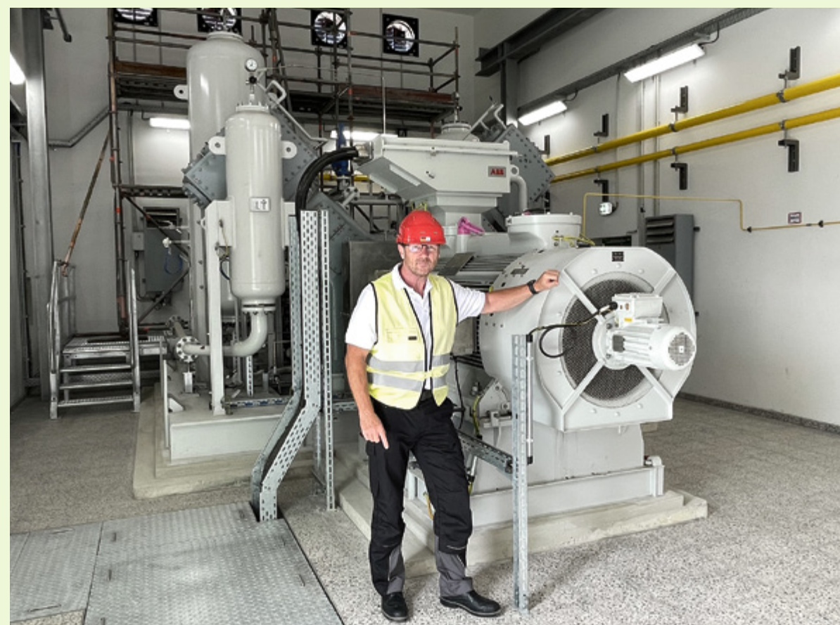
Der Leiter Technik, Jens Uhliar, im Herzstück der neuen Biogaseinspeiseanlage: Am Hauptverdichter wird das gelieferte Biogas komprimiert, um es ins öffentliche Gasnetz einleiten zu können.
