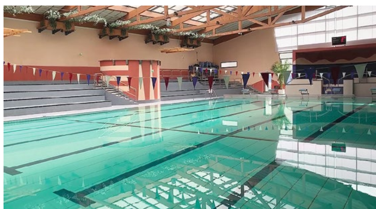
Das beliebte Sportbad im AquariUM kurz vor der umfangreichen Sanierung: Becken und Tribüne bekommen im Sommer neue Fliesen.
