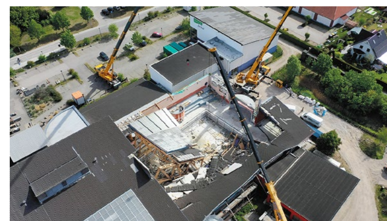
Die Rückbauarbeiten des eingestürzten Daches des AquariUM aus der Vogelperspektive. Foto: SWS
