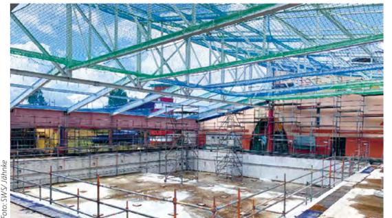
Die Stahldachkonstruktion über dem Sportbad vor Schließen der Dachhülle. Foto: SWS/Jährke
