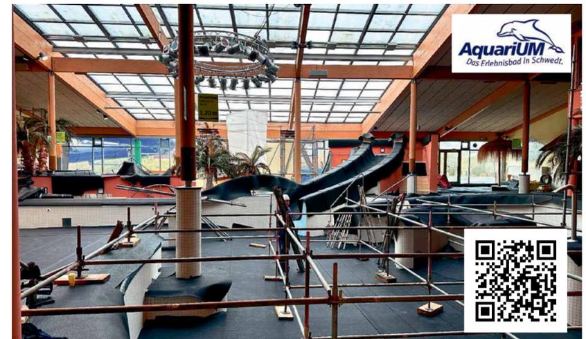
Das Spaßbad ist zum Schutz der anstehenden Dacharbeiten mit Gummiplatten ausgelegt. Foto: SW5
