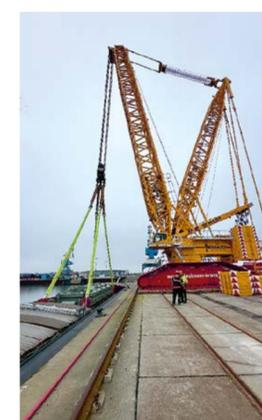
Am „Haken“: Der Raupenkran vor dem Heben des 355 Tonnen schweren Transformators. Foto: SWS/Beckmann
