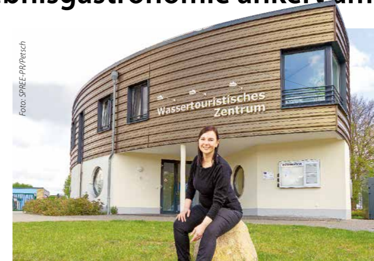
Im bootsähnlichen Haupthaus des StroamCamp laufen schon die Umbauarbeiten: Ireen Mieczkowski eröffnet diesen Sommer „Anker&Platz“, das Gästen auch Lust am Selberkochen bringen will.
